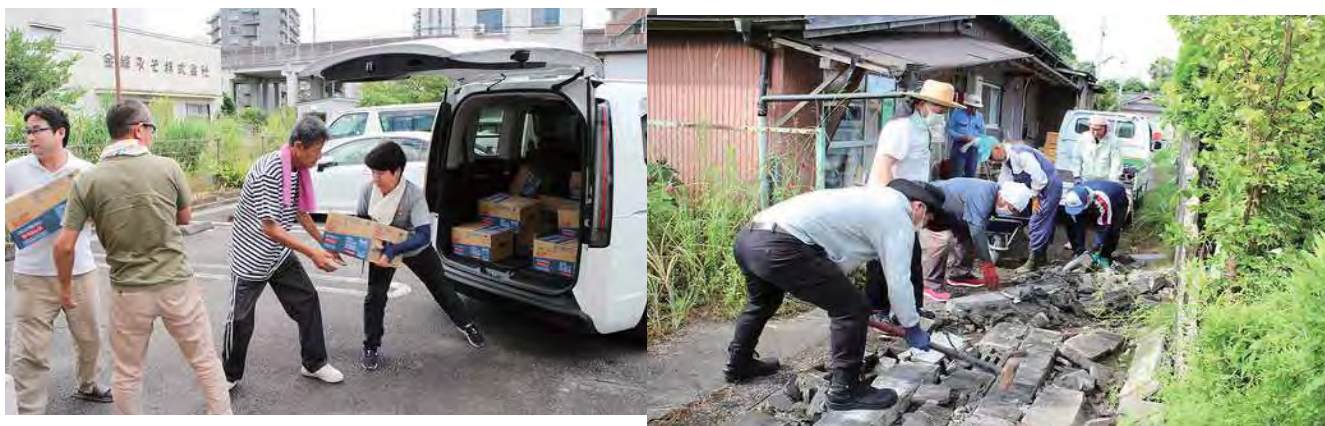
Tras el terremoto de magnitud 7,1 que sacudió Kumamoto el 28 de julio, los miembros del Centro del Dharma de Yatsushiro y un equipo de la sede central de la Rissho Kosei-kai llevaron a cabo operaciones de socorro, distribuyendo agua y retirando los escombros.
